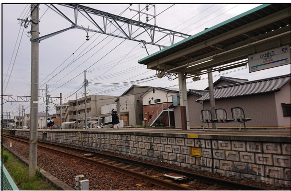
小垣江駅、一両分の屋根とその先のホーム
